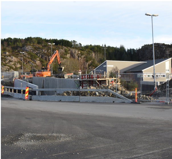
Ny kulvert under idrettsvegen i Øygarden var under bygging i 2022. Foto: Vagleik Brekk
