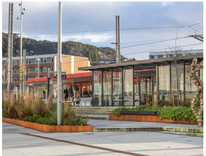
Ny kollektivterminal for buss og bane i Fyllingsdalen. Foto: Iver Daaland Åse
