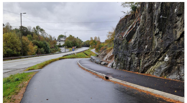
GS-løysing langs Nilsavegen stod ferdig i 2022. Foto Bjørnafjorden kommune
